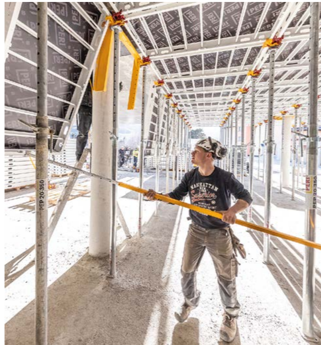
Mit der Einschalhilfe können Sie Deckenhöhen bis mindestens 3,80 m sicher schalen.
