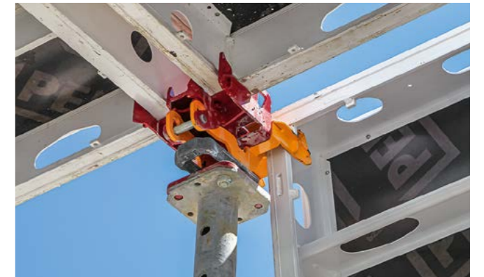
Dank der Zähne der Stütz- und Absenkköpfe sind die Paneele nach dem Einsetzen automatisch gegen Abheben gesichert.
