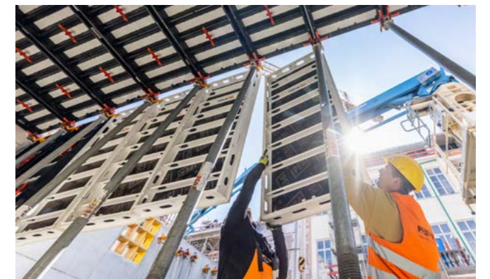
Aufgrund des geringen Gewichts und des ergonomischen Handlings genügen zwei Personen für die Montage der SKYMAX.
