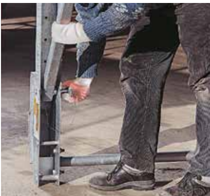
Die Stecker für die Montage der Druckstrebe sind unverlierbar an der Konstruktion befestigt. Werkzeug ist für die Montage nicht notwendig.
