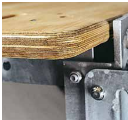
45 mm starker Bühnenbelag aus mehrfach verleimten Schichtholzplatten.
