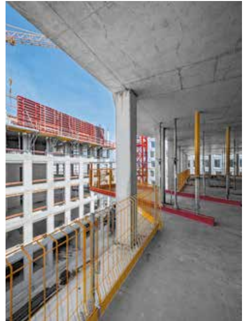
Für das Büro- und Hotelgebäude diente das Faltbühnensystem FB 180 als Arbeits- und Schalungsgerüst. Zum Umsetzen und Zwischenlagern von Schalungsmaterial war eine RCS MP Ausfahrbühne variabel platzierbar.
