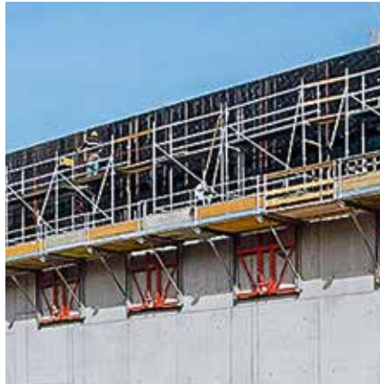
Die Falteckbühne im Einsatz an einer geraden Wand mit aufstehendem Bewehrungsgerüst PERI UP.
