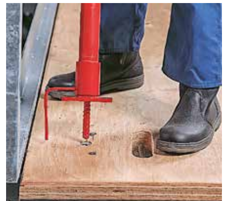
Der Stirnpfosten FBP zur Aufnahme der bau-seitigen Geländerbohlen wird in die Mehrzweckbefestigung (DW 15) eingedreht.
