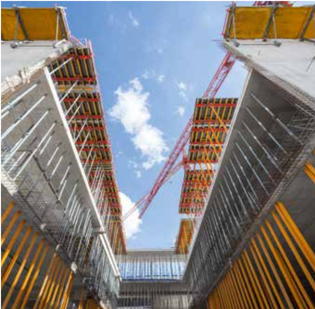
Die Faltbühne FB 180 in Kombination mit der MAXIMO Wandschalung sorgte für eine Einhaltung hoher Tempovorgaben.
