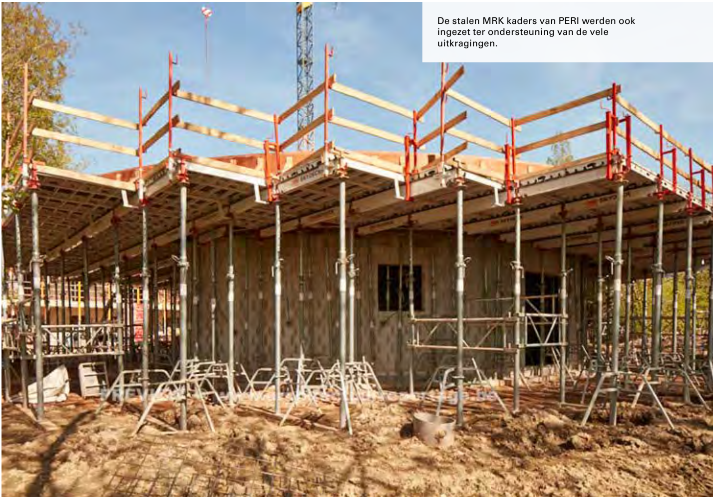
Stalen MRK kaders zorgen voor een grote stabiliteit.
