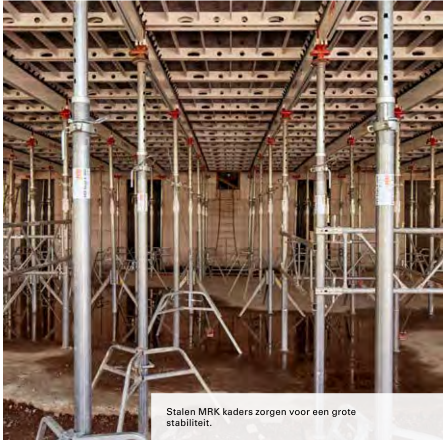
De stalen MRK kaders van PERI werden ook ingezet ter ondersteuning van de vele uitkragingen.
