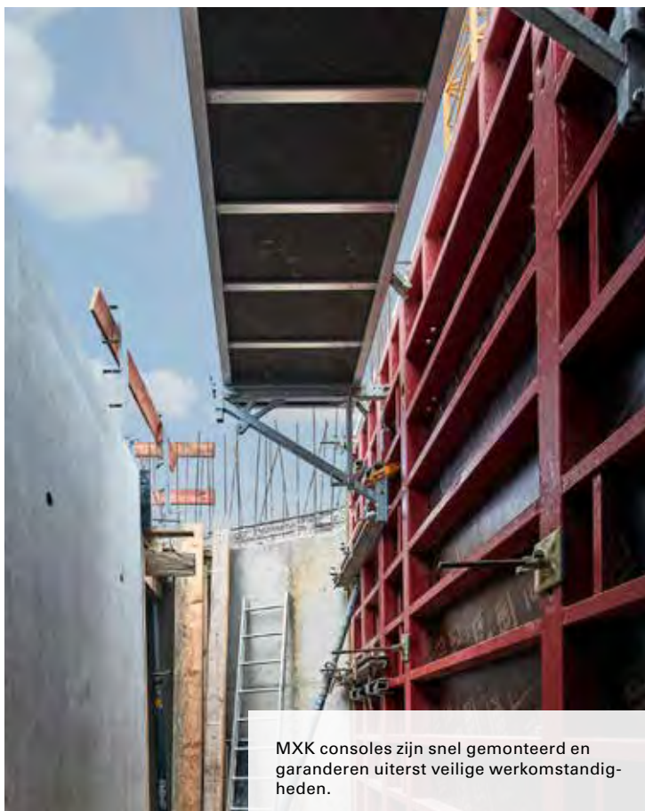
PERI MAXIMO levert een mooi egaal betonoppervlak en een symmetrisch centerpen- en naadpatroon op.
