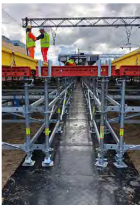
Project Zuidasdok, tijdelijke perronconstructies 2019
