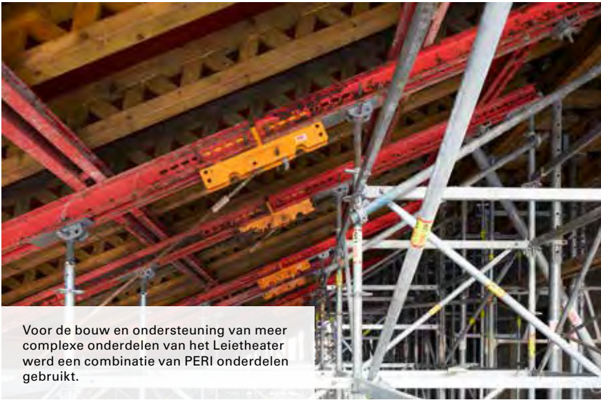
PEP Ergo schoren ondersteunen de zware bekistingslasten bij de bouw van de toneeltoren.
