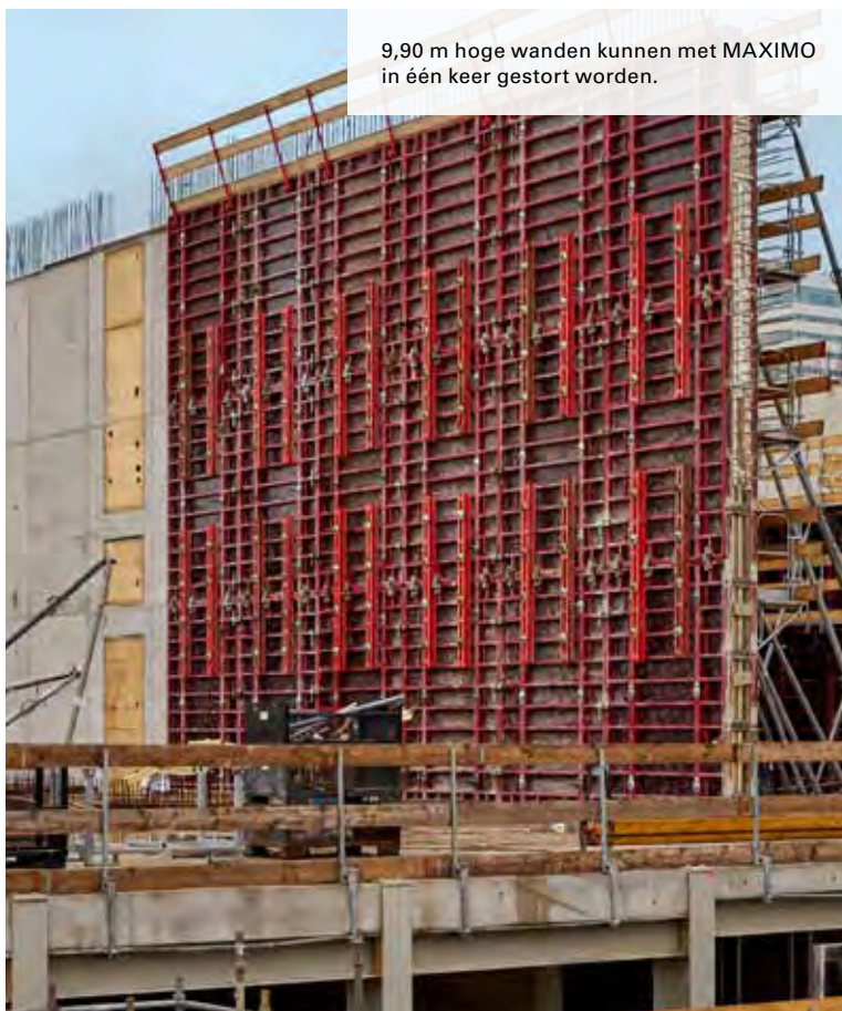
De MXK platforms zijn reeds aan de bekisting gemonteerd. Hierdoor zijn geen extra werksteigers vereist.
